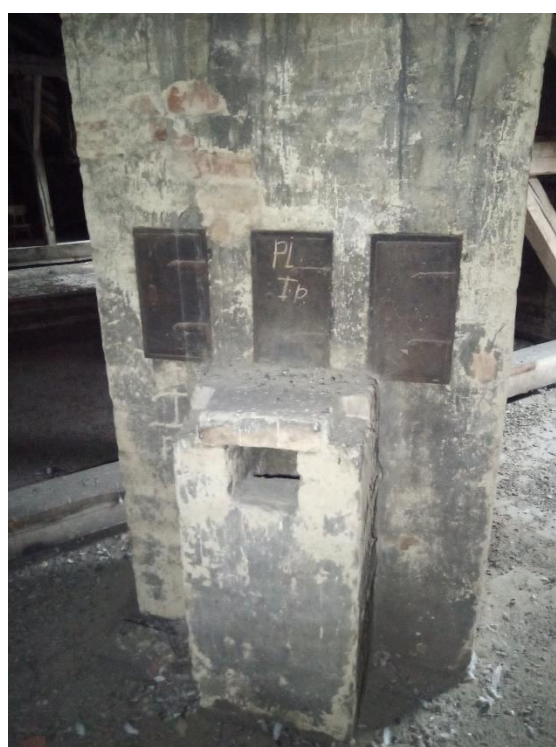
Foto č. 90 Komínové těleso v podkroví
