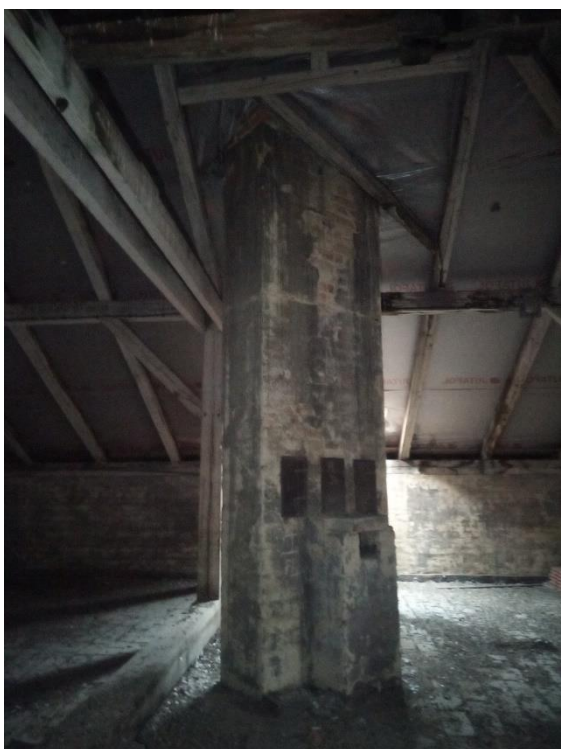
Foto č. 85 Konstrukce krovu
