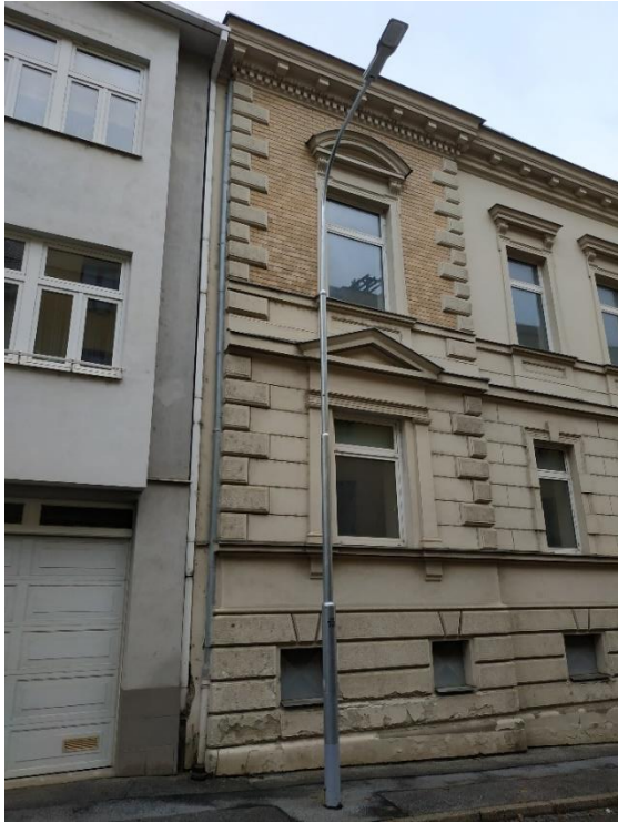
Foto č. 35 Fasáda z uliční části Kamenná
