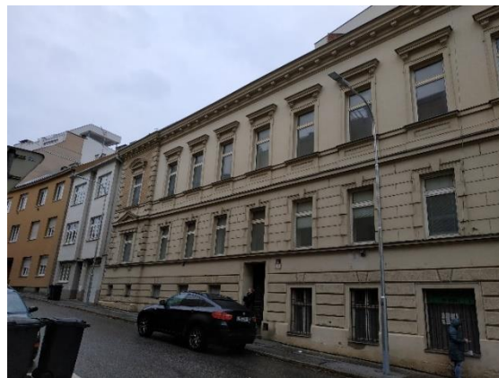
Foto č. 22 Fasáda z uliční části Kamenná
