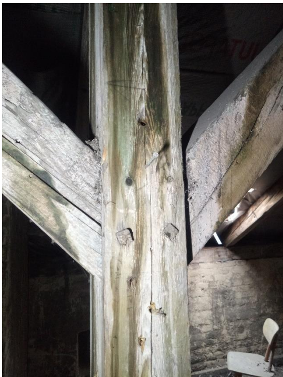
Foto č. 83 Konstrukce krovu
