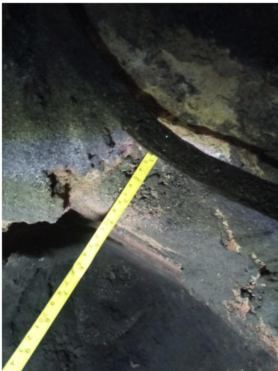
Foto č. 17 Sonda k základové spáře místnost 0.001.07
