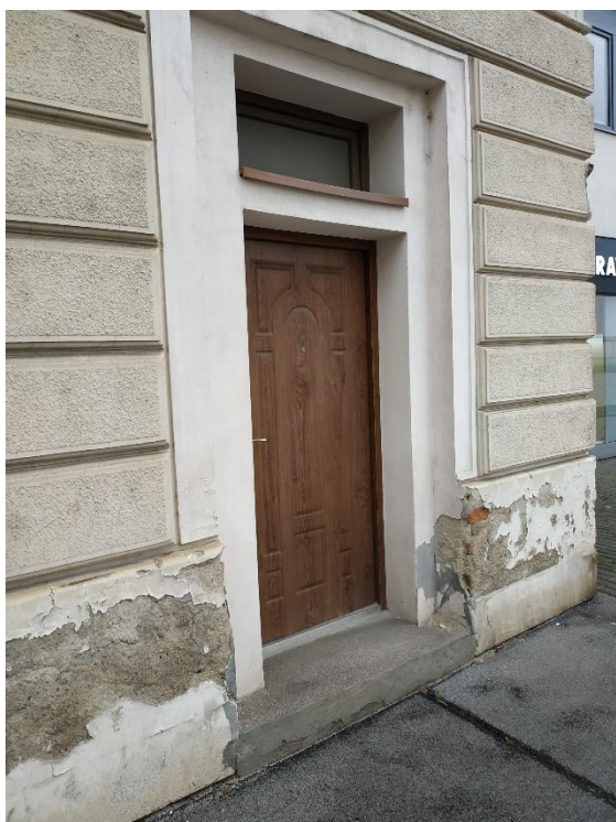
Foto č. 33 Hlavní vstup z ulice Vídeňská
