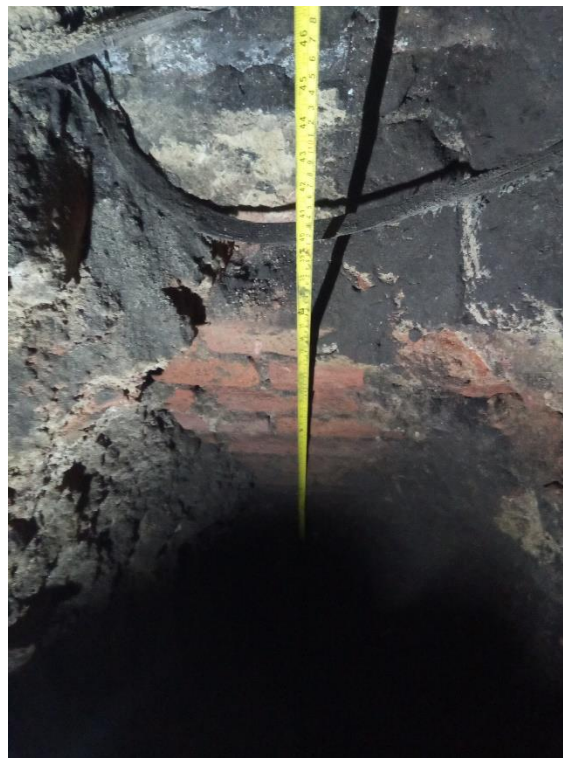
Foto č. 18 Sonda k základové spáře
