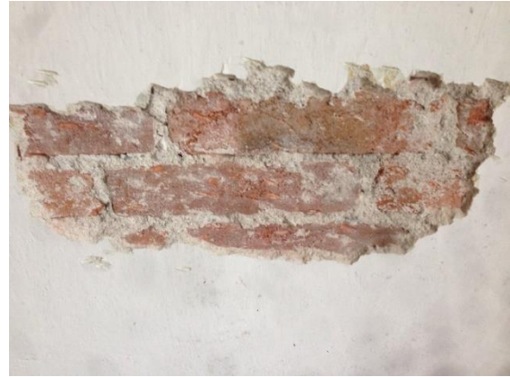
Foto č. 12 Sonda do zdi v místnosti 2.005.03
