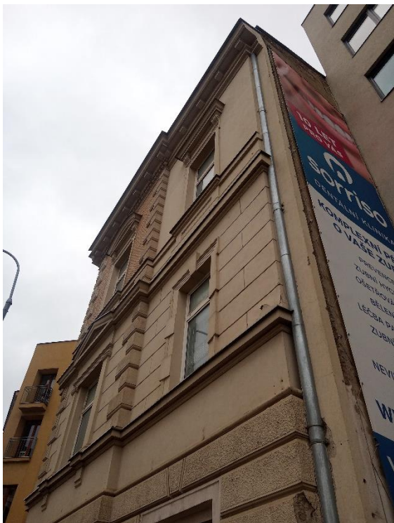
Foto č. 27 Fasáda z luční části Vídeňská
