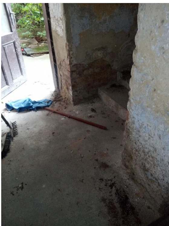
Foto č. 45 chodba 0.001.01
