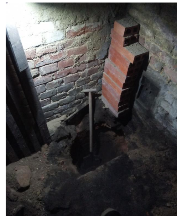
Foto č. 16 Sonda k základové spáře místnost 0.001.07
