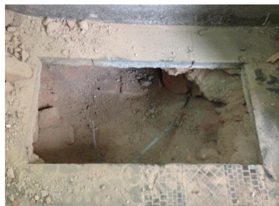
Foto č. 14 Sonda do podlahy na chodbě 1.000.02
