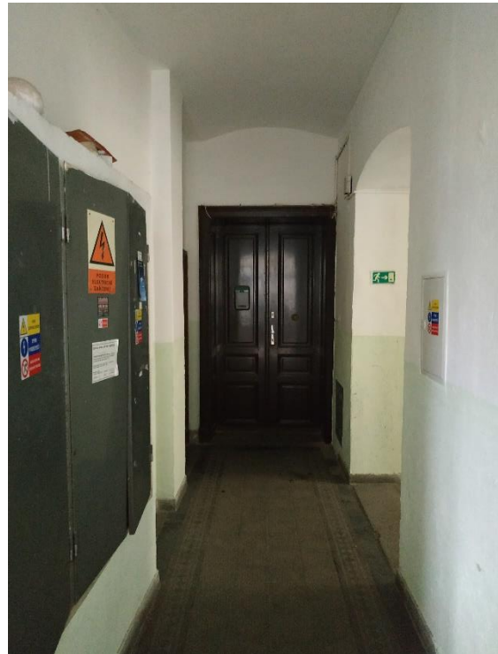
Foto č. 56 Chodba 1.000.02
