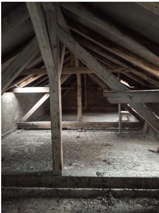
Foto č. 87 Konstrukce krovu
