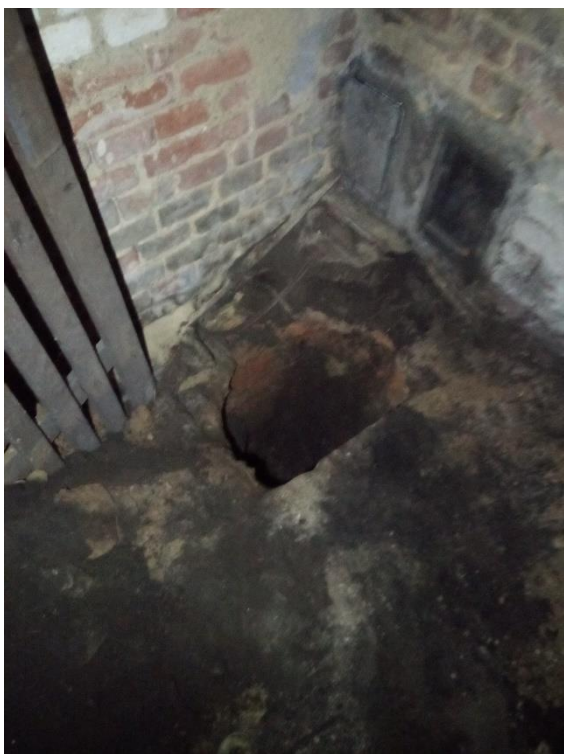
Foto č. 19 Sonda k základové spáře místnost 0.001.07
