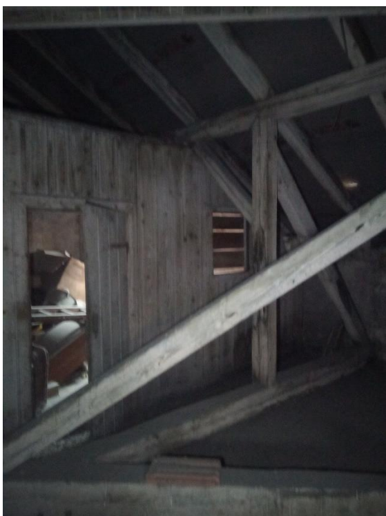
Foto č. 89 Konstrukce krovu
