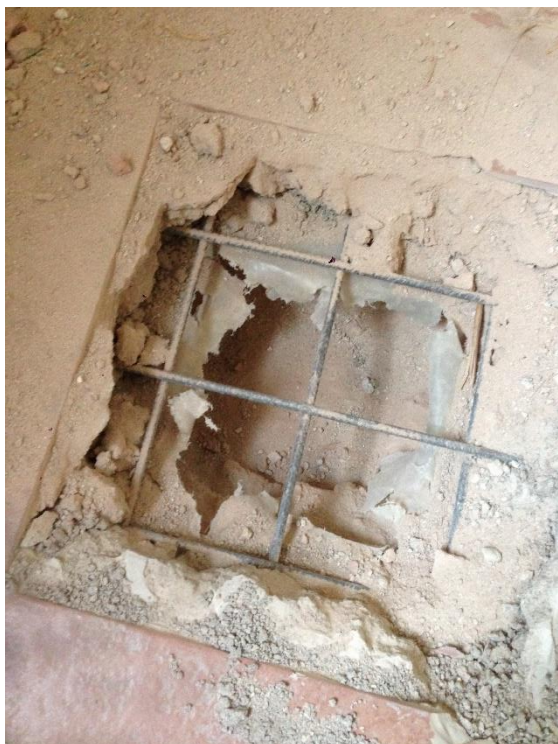
Foto č. 7 Sonda do podlahy v místnosti 2.005.03
