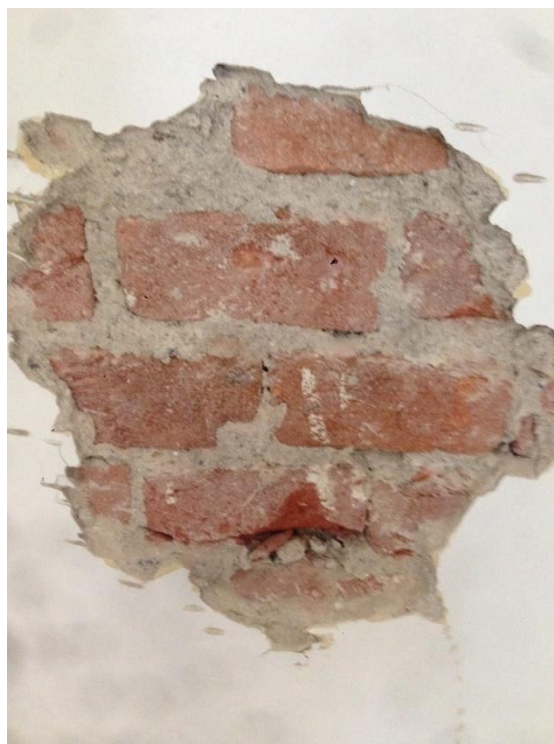
Foto č. 8 Sonda do nosné zdi v místnosti 2.004.06
