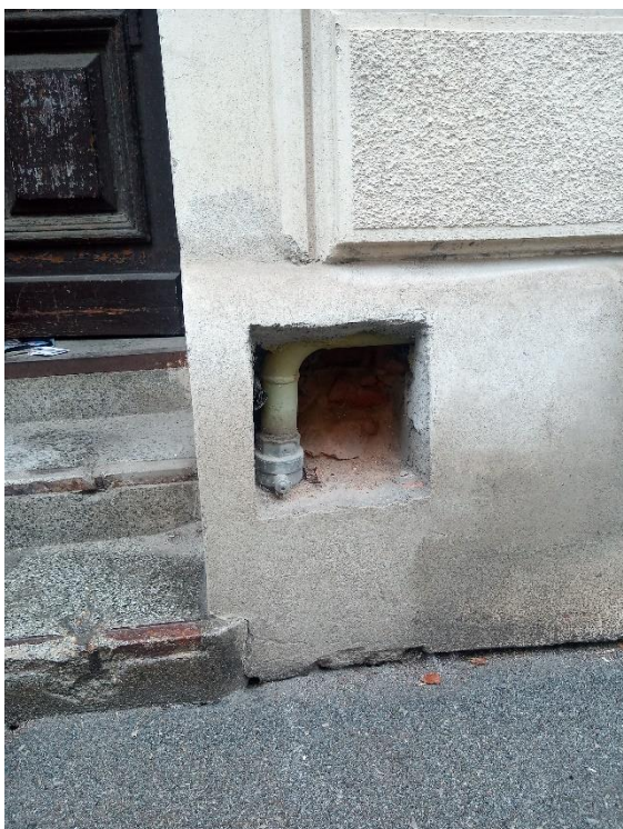
Foto č. 29 Plynovodní přípojka z ulice Kamenná
