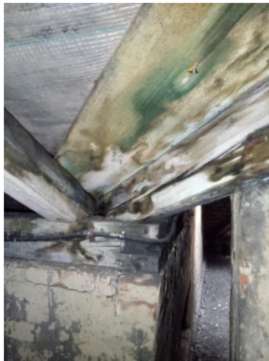
Foto č. 88 Konstrukce krovu
