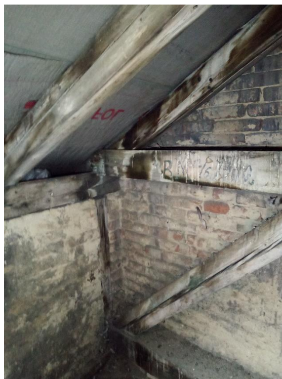
Foto č. 86 Konstrukce krovu
