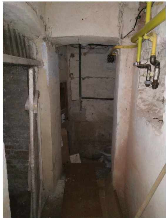
Foto č. 38 Chodba 1.PP 0.001.02
