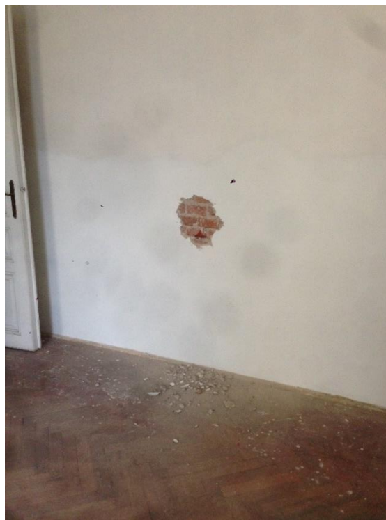
Foto č. 10 Sonda do nosné zdi v místnosti 2.004.06
