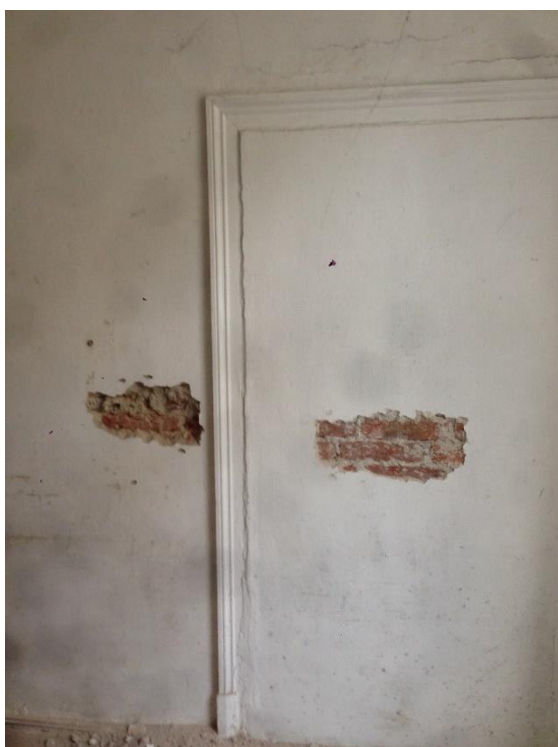
Foto č. 9 Sonda do zdi v místnosti 2.005.03
