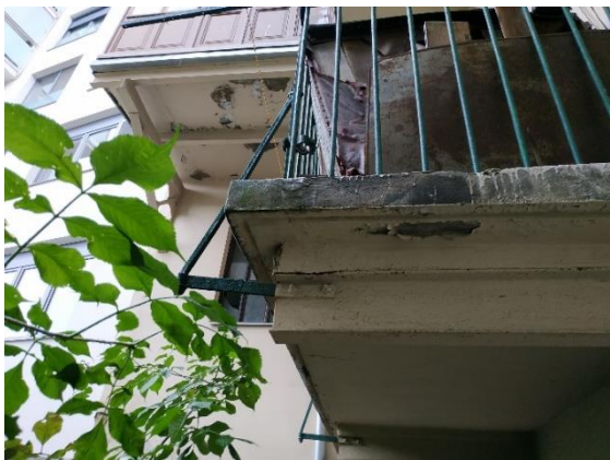
Foto č. 47 Konstrukce pavlače 1.000.04
