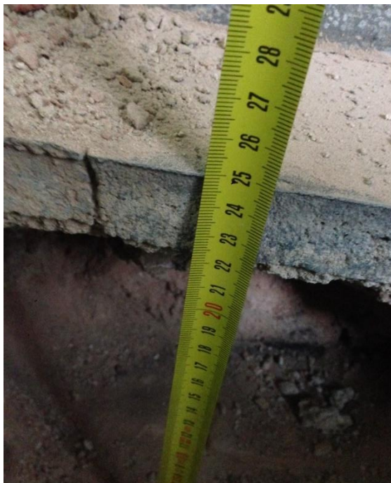
Foto č. 15 Sonda do podlahy na chodbě 1.000.02
