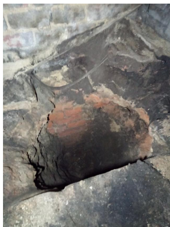
Foto č. 20 Sonda k základové spáře
