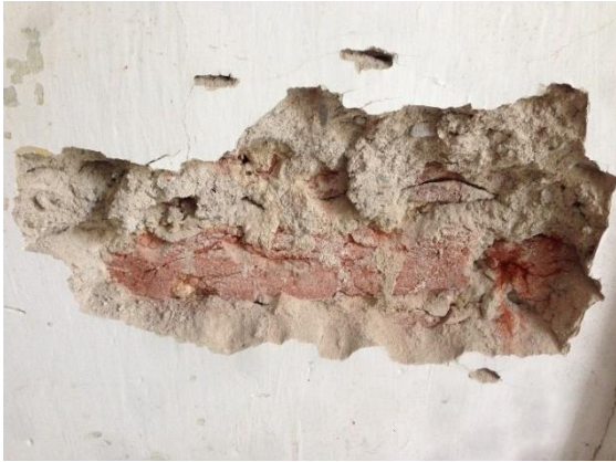
Foto č. 11 Sonda do zdi v místnosti 2.005.03
