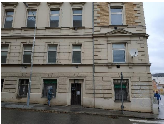
Foto č. 21 Fasáda z uliční části Kamenná
