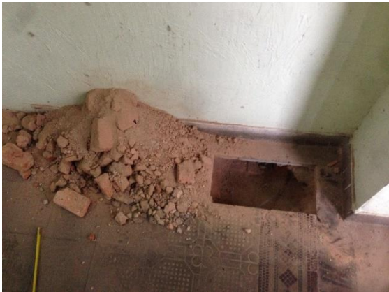
Foto č. 13 Sonda do podlahy na chodbě 1.000.02
